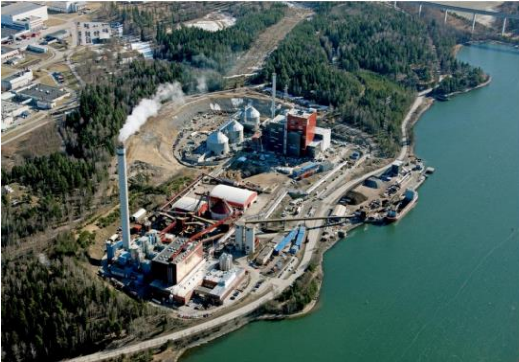
Figur 1: Igelstaverket med värmeverket i förgrunden och kraftvärmeverket i söder.
