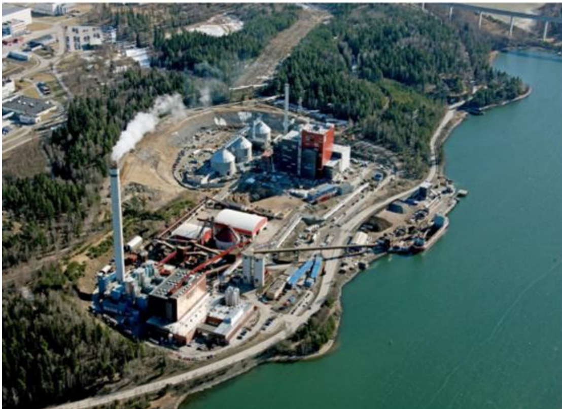
Figur 1: Igelstaverket med värmeverket (IGV) i förgrunden och kraftvärmeverket (IKV) i söder, samt Igelstakajen där bränsle lossas.
